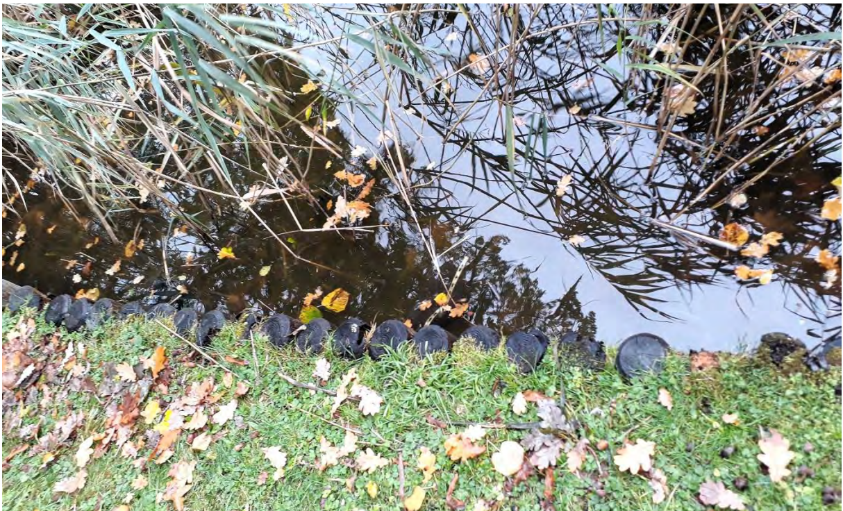
Uferverbau mit Eichenholzpfählen an der Tribseer Bastion, 2024, Foto: Angela Pfennig
